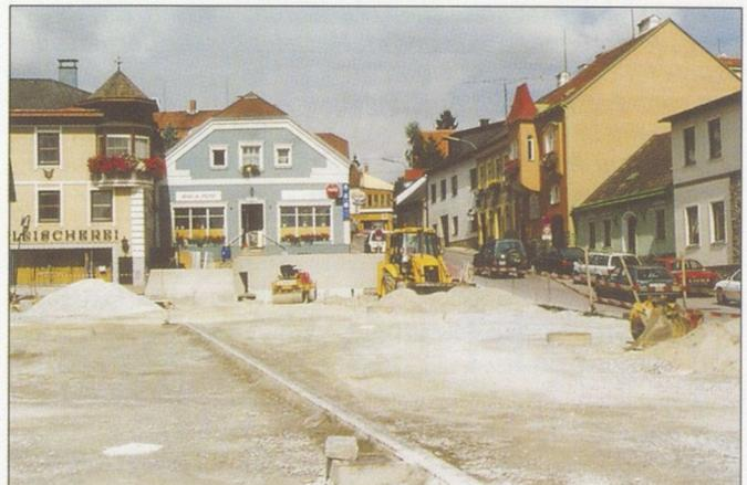
Im Zeitplan: Unterbau ist fertig, die notwendigen Leitungen (Strom, Kanal ..) sind verlegt, demnächst kommt Belag
