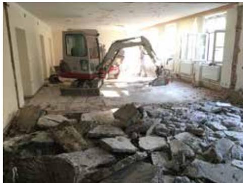
**22. August 2018:** Die gesamte Fußbodenkonstruktion in Teilbereichen des Erdgeschoßes wird entfernt.
