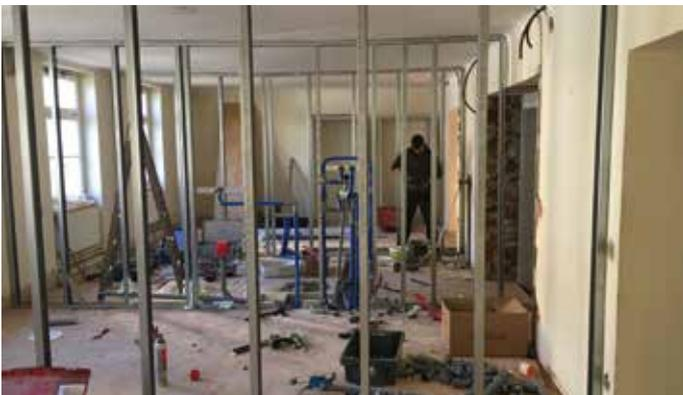
30. Oktober 2018: Einbau von Raumtrennwänden im Erdgeschoß
