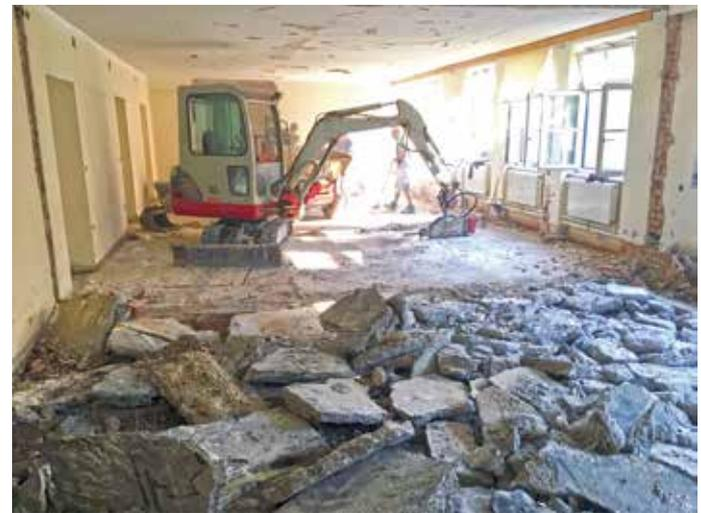
Die gesamte Fußbodenkonstruktion in Teilbereichen des Erdgeschoßes musste entfernt werden, um die Setzungsschäden nach dem Hochwasser von 2002 beheben zu können. (Aufnahmedatum: 22. August 2018)
