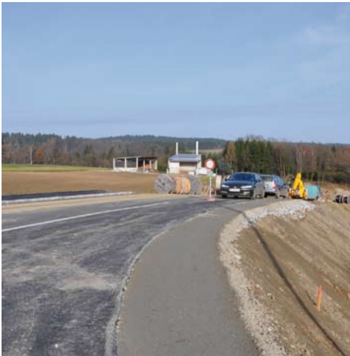
Aufschließungsarbeiten im neu entstehenden Betriebsgebiet
