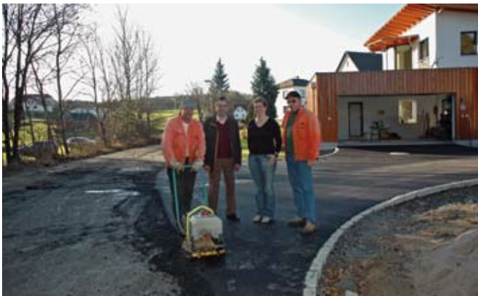
In Waldhams wurde eine neue Siedlungsstraße angelegt.
