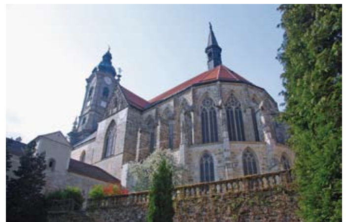
Innensanierung der Stiftskirche wird unterstützt.
