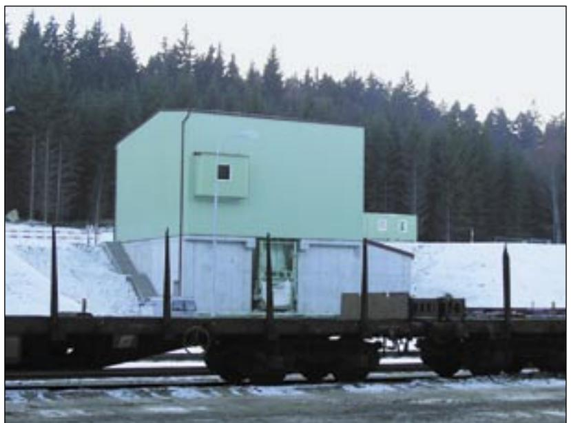
Beim Bahnhof Kleinschönau wurde heuer von den Abfallverbänden Zwettl und Gmünd eine Müllumladestation errichtet: Die Abfälle werden hier in Container gepresst und per Bahn zur zentralen Müllverbrennungsanlage Dürnrohr transportiert.
