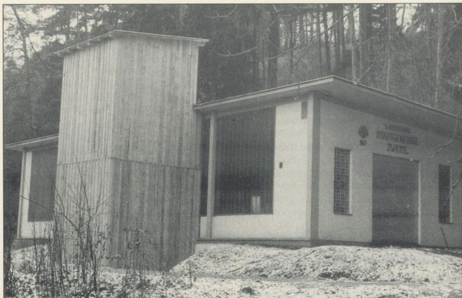
Das Zwettler Wasserwerk mit dem zugebauten Aktivkohlefilter, der zum Schutz vor Kälte mit einer Verschalung versehen wurde
