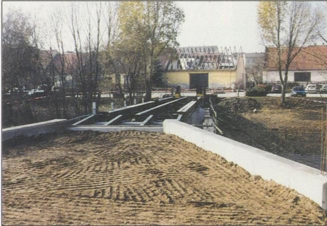
Blick vom Kampufer in Richtung Stadtzentrum: Am 6. November ist noch die Scheune in der Gartenstraße zu sehen, die wenige Tage später abgerissen wurde. Die Stahlträger der Brücke sind bereits montiert. Im Vordergrund sichtbar sind die Vorbereitungen für die Asphaltierung der Brückenrampe.
