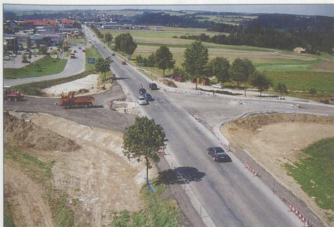
...und so sah der Bereich am 30. August 2001 aus. Unser Bild entstand in ca. 17 Meter Höhe: In der vorletzten Bauphase wurde an der Herstellung des Mittelkreises gearbeitet.
