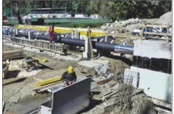
Auf dieser, ebenfalls am 25. September entstandenen Aufnahme ist die Ausführung des Lüftungsrohres bzw. der Lüftungsinstallationen für den Hallenbadbereich zu sehen.
