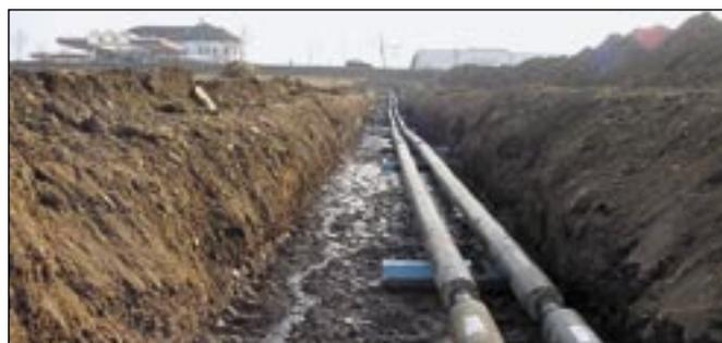
Ein sechs Kilometer langes Fernwärmeleitungsnetz wurde in den vergangenen Monaten errichtet. Bild: EVN Zwettl
